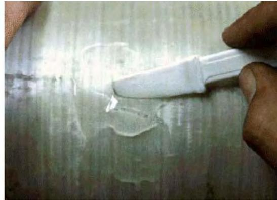
Si une protection complémentaire est requise, appliquer un morceau plus grand que le défaut de tissu en fibre de verre sur la zone endommagée. Appliquer une fine couche de résine sur le voile, en veillant à ce que le voile et la zone endommagée soient entièrement couverts.
